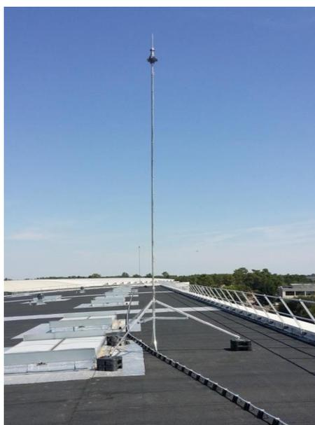
Active<sup>®</sup> fixé avec des pattes AFZ0420PD / trépied AFD3300FS et dalles AFH8045DA
